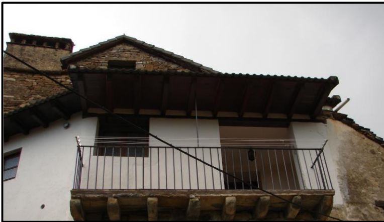
← Solana de casa Leandro .
