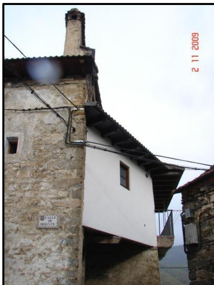
Casa Leandro con chimenea rectangular
