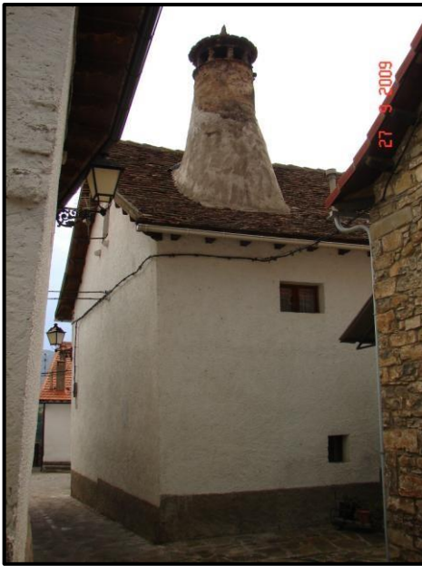
Casa Casalera con chimenea troncocónica.
